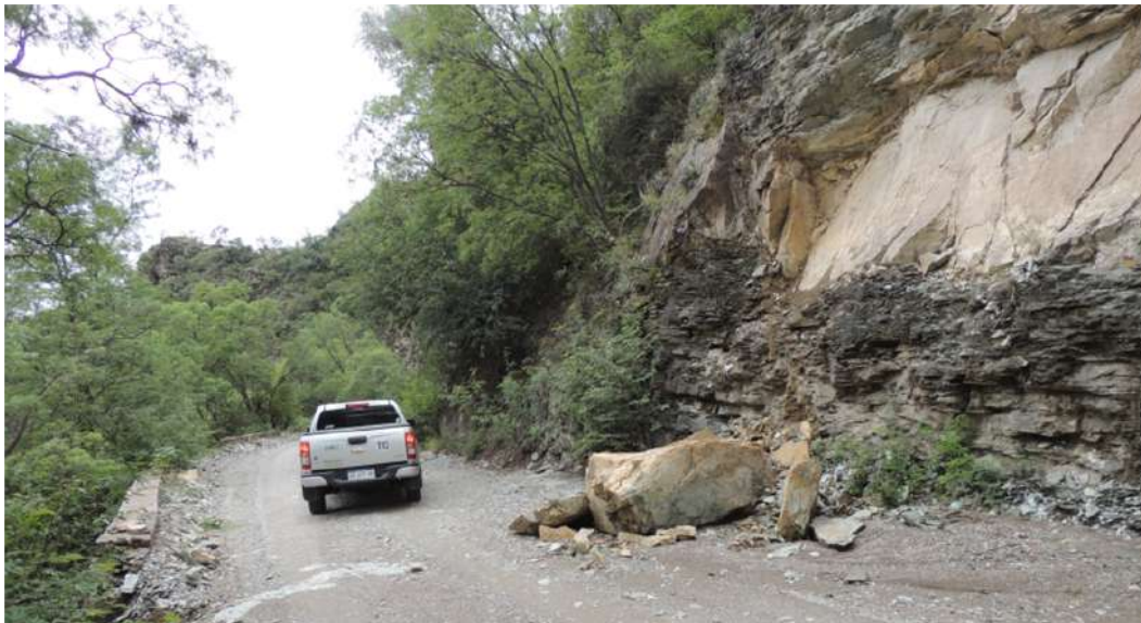
Figura 29. Caída de bloques después de una lluvia en el tramo de las Filitas
